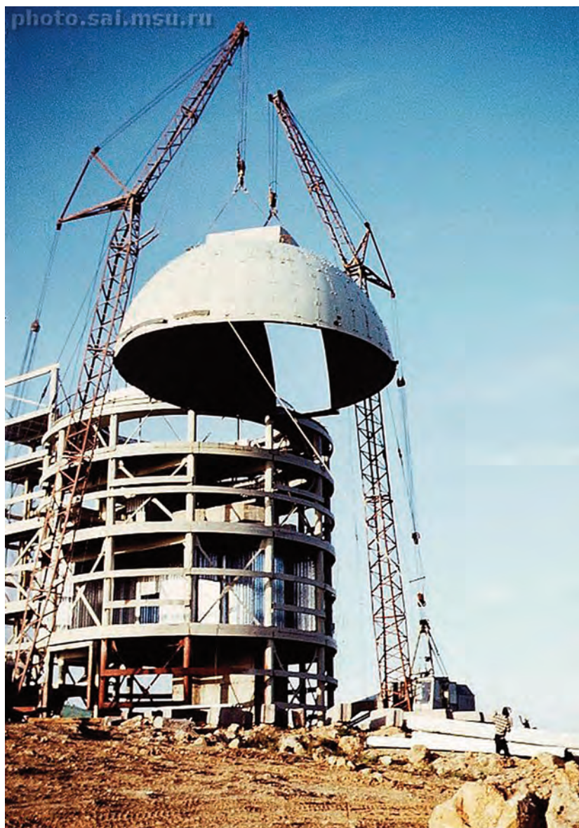
Установка купола на АЗТ-22
